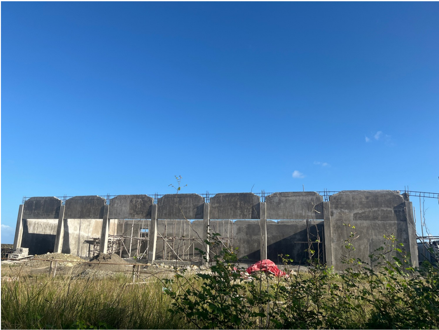
Pembangunan Kantor Koperasi Merah Putih
